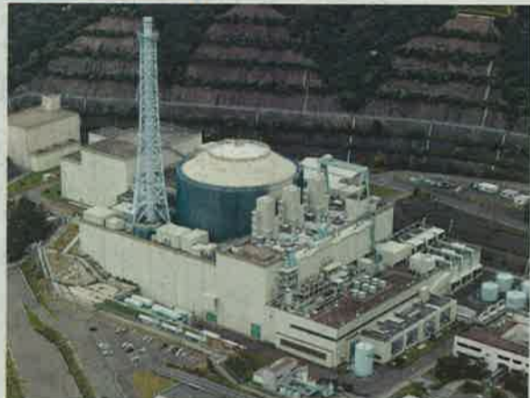
福井県敦賀市の高速増殖炉「もんじゅ」(本社ヘリから)
